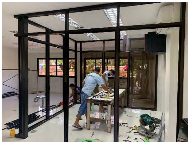
図 6 フィリピン大学ロスバニョス校のサーバ室の施工状況（2022 年 1 月時点）
