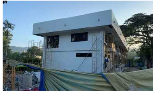
図5 専用ルームを増設予定の建設中の建物
