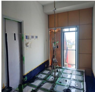
図9 ハイブリッド床冷却システムの現地実測の様子(Tegal 実験棟)
