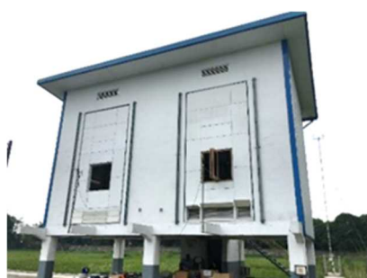
図8 ジャカルタ郊外の実験住宅 (YKK AP インドネシアの実験棟)
