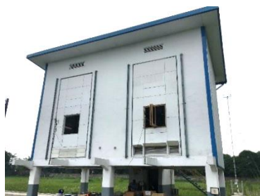
図4 ジャカルタ郊外の実験住宅 (YKK AP インドネシアの実験棟)
