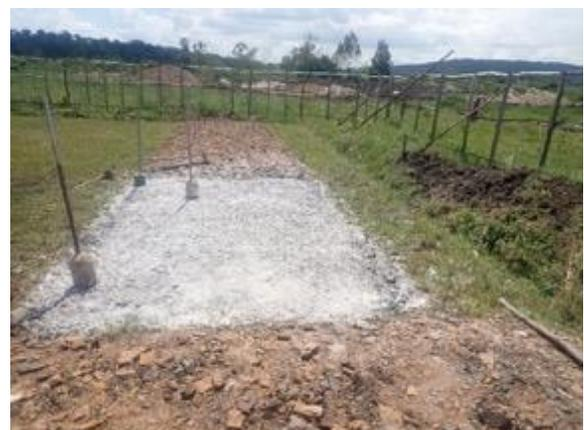
図 3-10 路床改良層の締固め後
