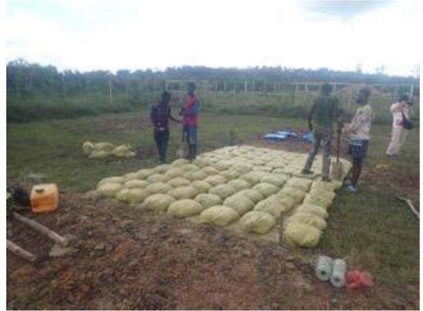
図 3-12 土のうにより路盤を構築
