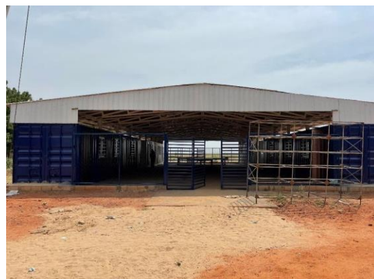
図 3 ワドメダニに設置した作業場
