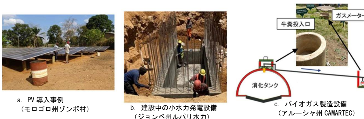
図 5-5 無電化村落に導入された再エネの事例
