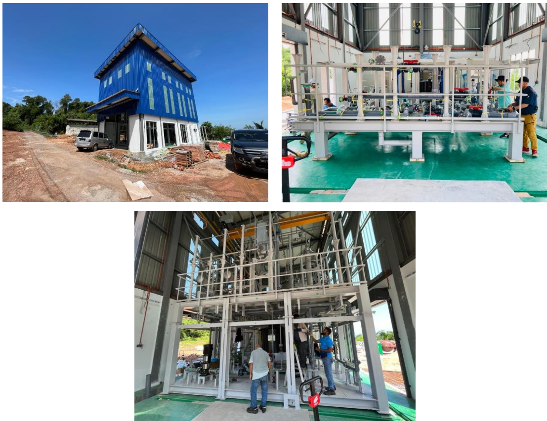
図 3 : マレーシア現地での組立実施の様子
