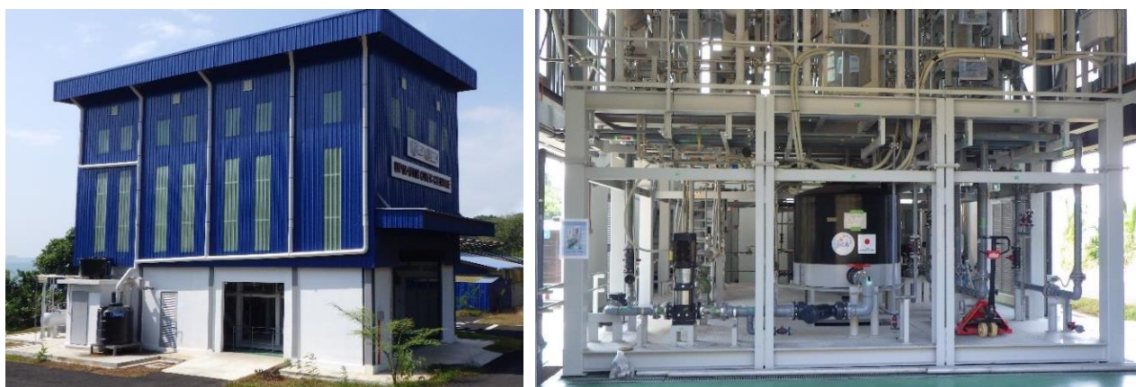
図 2 : UPM-UTM OTEC CENTRE および H-OTEC 試験装置
