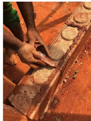
写真6 土ブロックの試し積み
