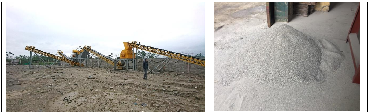
図 6 ハノイ市内に設置した破砕機：左）全景、右）試験的による製造したコンクリート碎石
