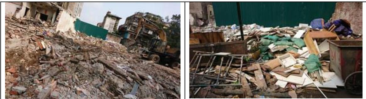
図 1 ハノイ市内の環状道路拡張工事ともなう周辺建屋の解体工事現場（2018 年 3 月）
