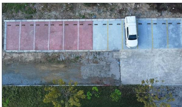
HUCE ハナムキャンパスでのパイロット試験 (実規模駐車場施工)。左：施工中の様子、右：施工後の上空からの様子 (赤褐色が再生材透水舗装区で、灰色が通常の天然資材コンクリート舗装区)
