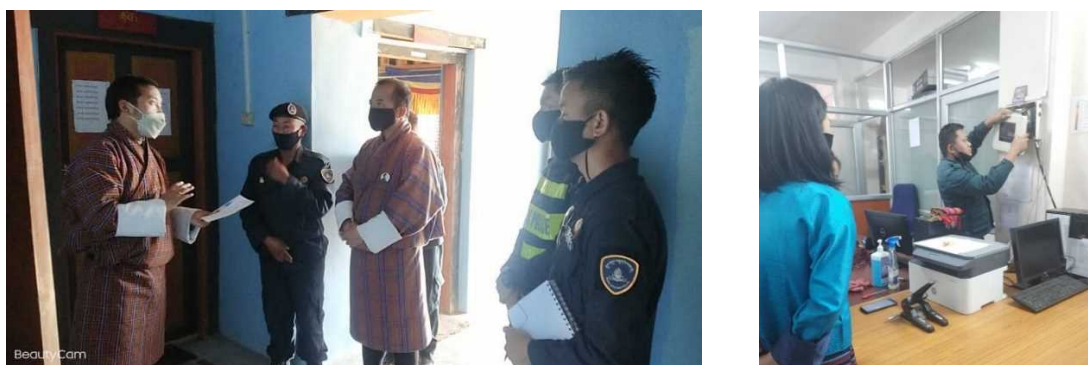
図 2-2-3：震度計設置作業。Gewog 職員への説明（左）、Gewog オフィス壁への震度計取付け（右）
