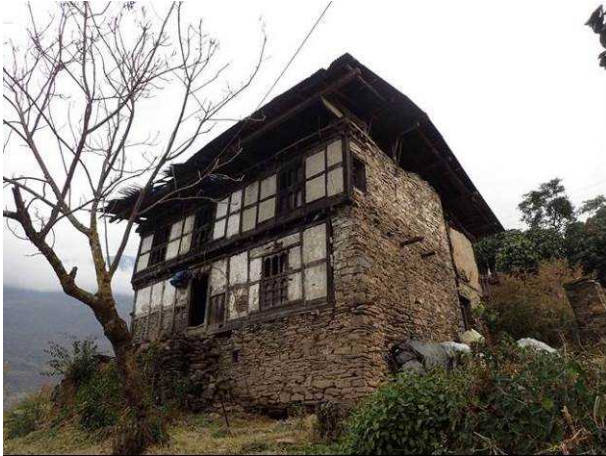
図 4-1：長期モニタリング対象石造建物
