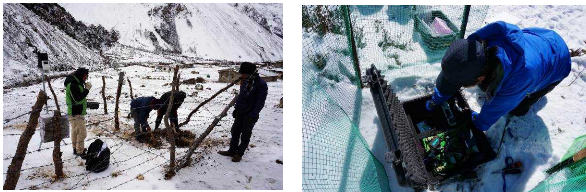
図 2-2 : 2018 年 2 月末から 3 月初頭にかけてのオフライン点の保守作業。Jangothang から Soe への移設 (左) および Thanza での保守作業 (右)。
