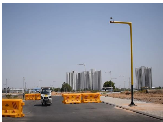
CCTV による車両検知
