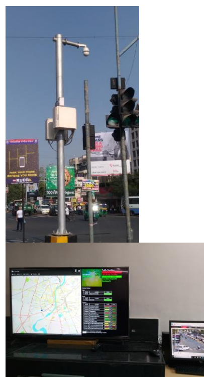
図 12 交差点カメラとモニター装置
