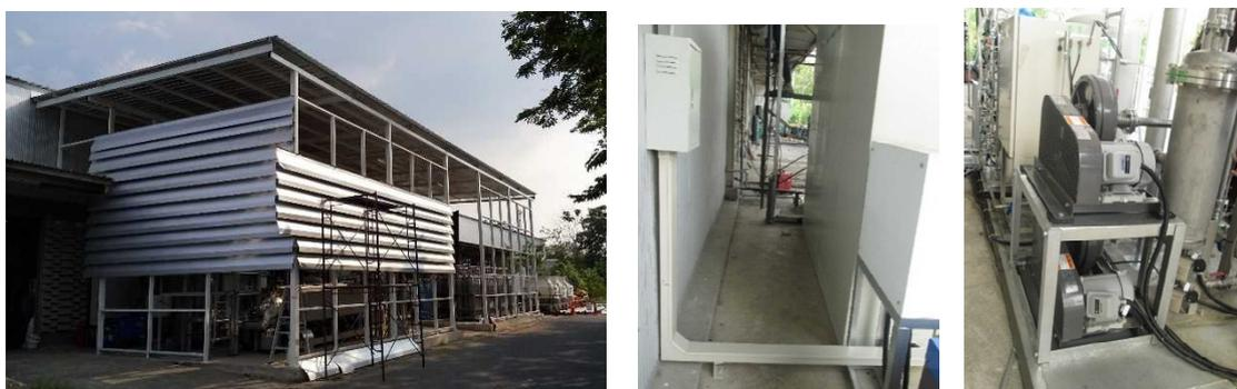
図 9 （左）対候対策（外壁カバー等）、（中・右）供与機材の追加・調整等（カバー・ブロワ等）
