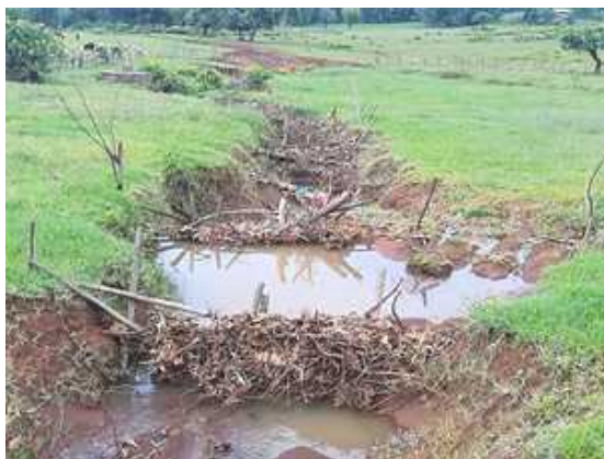
写真2. アバガリマにおけるチェックダムによるガリ侵食防止
