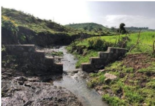
写真 1. 土砂・流出モニタリング用の堰
