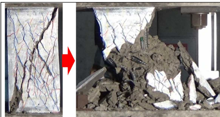
写真9 柱の崩壊性状@東京大学 (2017年10月)
