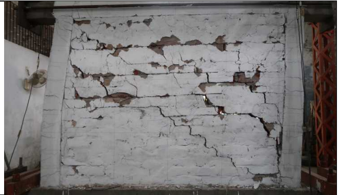
写真8 組積造壁を含むRC造フレームの破壊状況@HBRI (2019年2月)
