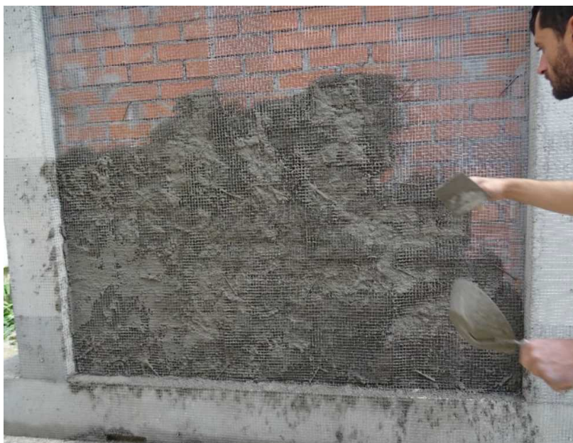
図 4. バングラディッシュでの Ferro Cement を用いた無補強組積造壁の補強状況.
