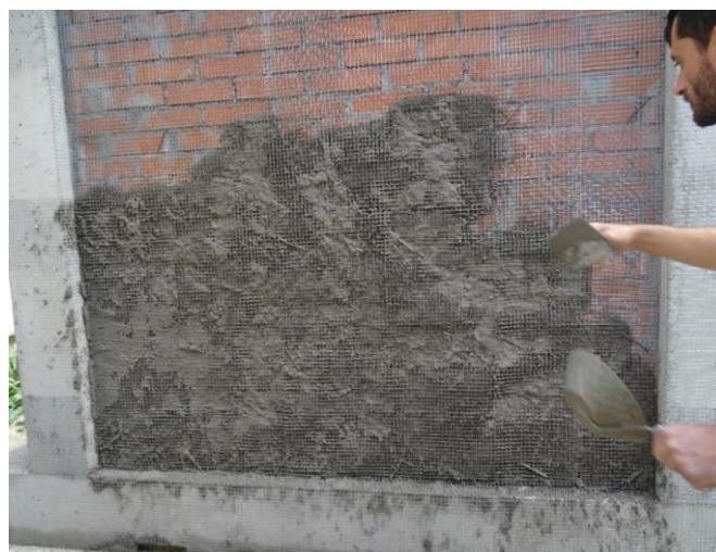
図 6. バングラデシュでの Ferro Cement を用いた無補強組積造壁の補強状況.
