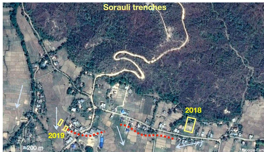
図 7. ブトワル西方ソラウリ地区トレンチ調査地点。ヒマラヤ前縁断層（赤破線）は樹林に覆われた丘陵の南端と低地の境界から地下を低地側に前進して、トレンチ南側の道路付近で浅い地下に達している。
