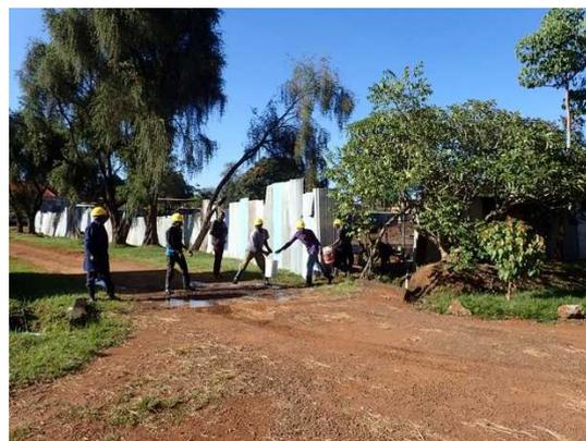
図1-4 基礎工事中の掘削場所にたまった水をバケツリレーで汲み出している
