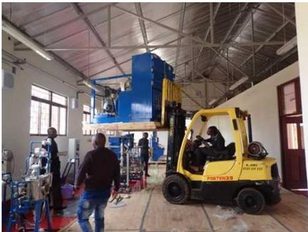
図 1-1 製糸機械の設置作業
