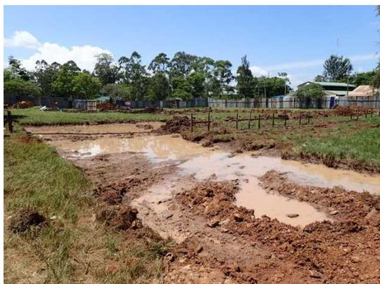
図1-3 カイコ飼育実験棟建設現場。基礎工事の掘削中に大量の水がわき出てきた。
