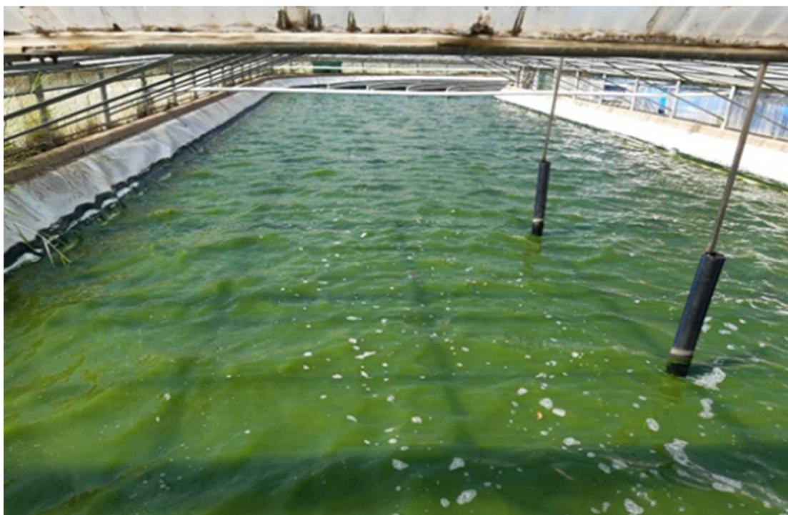
Fig. 1-1. Kingsburgh 下水処理場に設置したレースウェイ型 300ton ポンド
