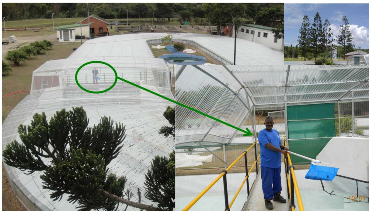
図 1-1 南アフリカ共和国 eThekweni 自治政府が管理する Kingsburgh 下水処理場内に、ダーバン工科大学が設置した、培養液重量 300ton の微細藻類培養プール (白色の屋根: 面積 1000m<sup>2</sup>) と、培養液重量 3ton の微細藻類培養プール (中央上部の水色の小型プール)
