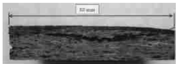
図 3.1-3 割れが発生したアグリボードの切断断面の外観
