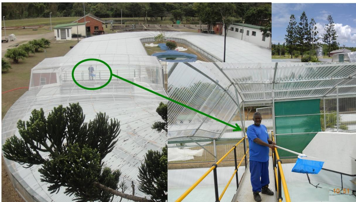
図 1-1 南アフリカ共和国 eThekwini 自治政府が管理する Kingsburgh 下水処理場内に、ダーバン工科大学が設置した、培養液重量 300ton の微細藻類培養プール (白色の屋根: 面積 1000m<sup>2</sup>) と、培養液重量 3ton の微細藻類培養プール (中央上部の水色の小型プール)
