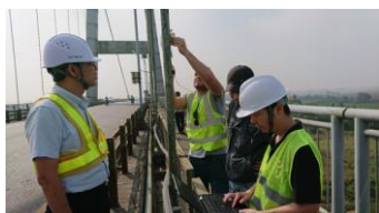
Patheingyi 橋のケーブル振動推定
