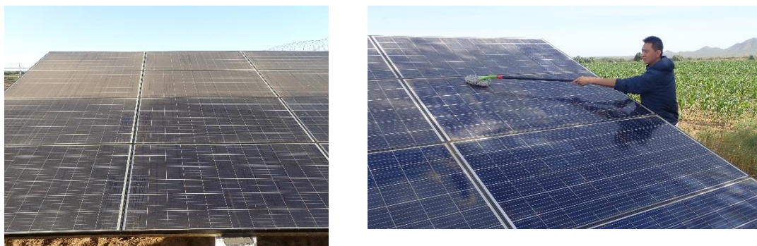
図 32 砂塵が堆積した太陽電池パネルの概観と清掃作業の様子
