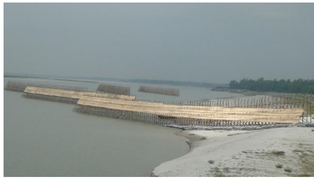
図 3.3 Kazipur に設置したバンダル型水制（2018 年 5 月 14 日現在）。7 月の洪水で手前の水制（一部破損）を残して大部分が流失した可能性が高い
