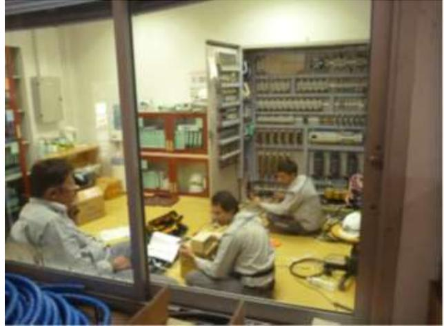
写真 4-4 計電装ケーブル結線工事の状況
