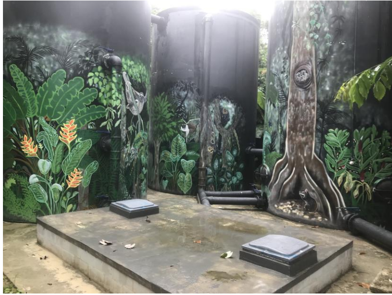
森に溶け込むように動植物の描かれたタンク
