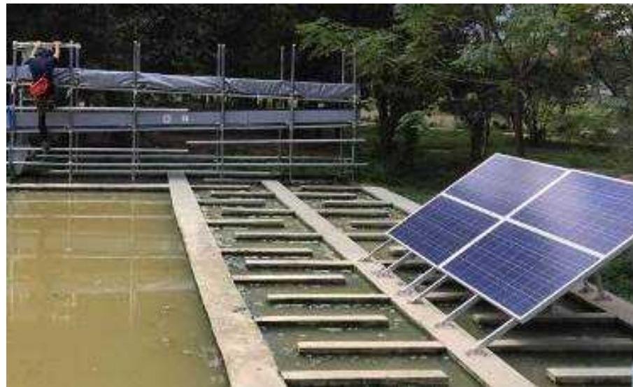
図 4.5 Jwagal 水処理場に設置した大型スポンジ傾斜水処理装置
