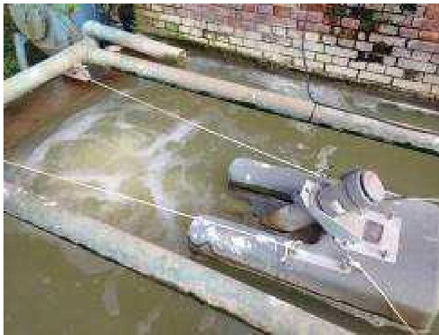
図 4.6 Jwagal 給水場に設置した小型曝気装置
