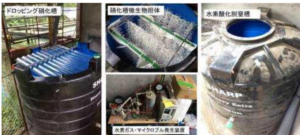
図 4.2 Jwagal 給水場に設置したドロッピング硝化-水素酸化脱窒装置
