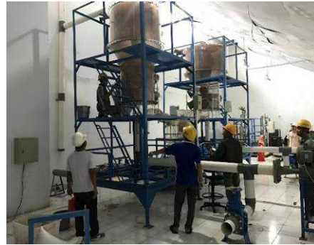
流動化試験の様子
