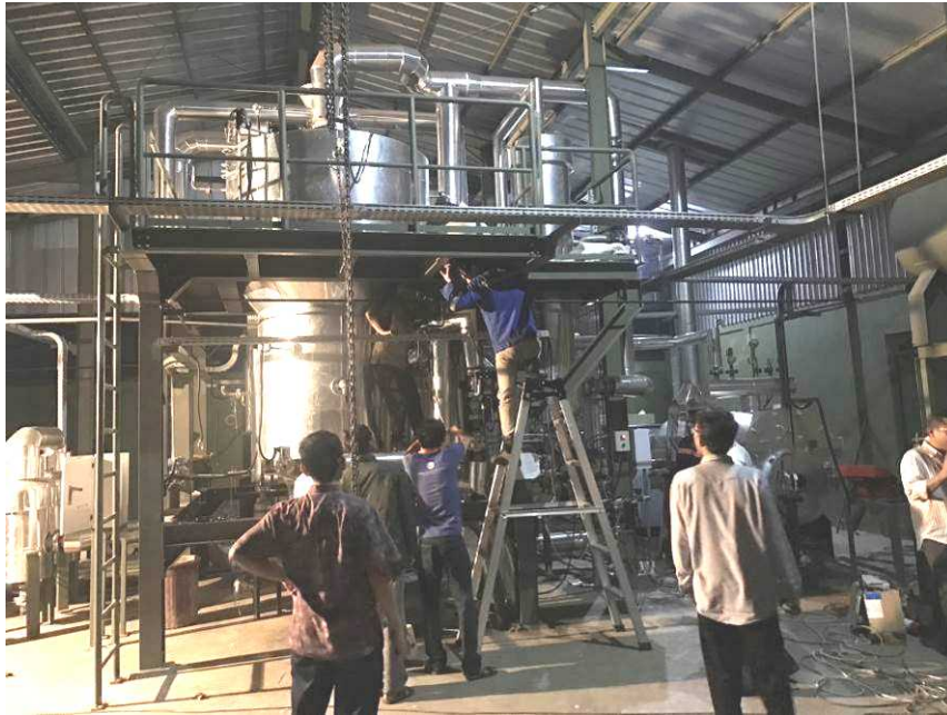
図 1-6-2(3) 竣工したパイロットスケールデモンストレーションプラント
