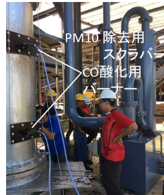
図 9. パイロットプラントの排煙処理装置
