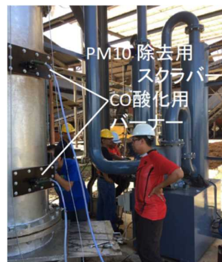
図19. パイロットプラントの排煙処理装置
