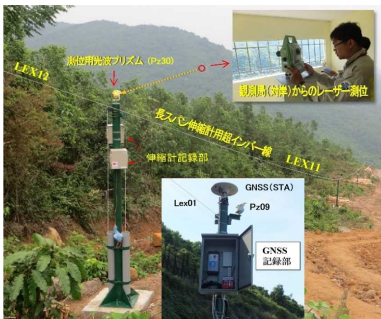
図 10-2 ハイバン斜面に設置した地すべり計測システムの写真
