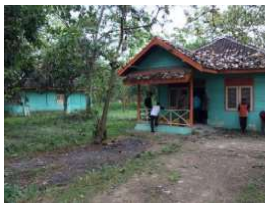
ITB 機器の保管倉庫(森林公社倉庫)
