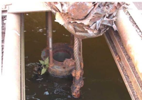
図 1-7 自噴を停止したマヌン湖のガス抜きパイプ
