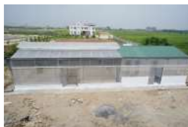
ベトナム農大に建設した育種交配室と網室
