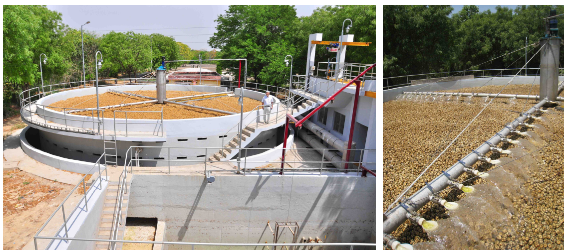
写真 1 アグラ市の下水処理場に建設した DHS リアクターの全景
