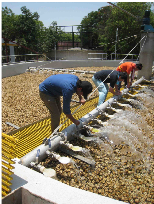
写真 2 自走式散水装置の回転速度調整の様子
