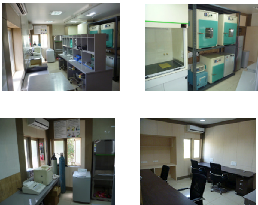
図4 アグラ実験室・事務所の改修工事
