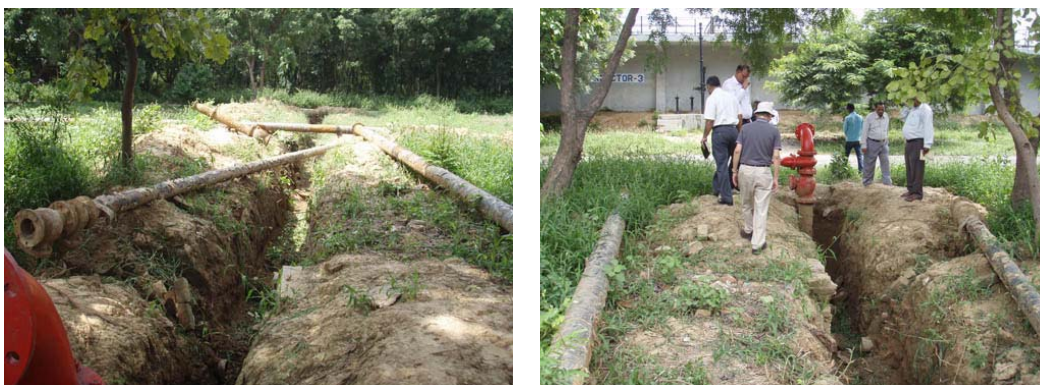
図 1 埋設管の撤去の様子
