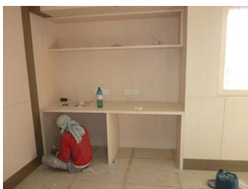
図 7 事務所の改修工事
