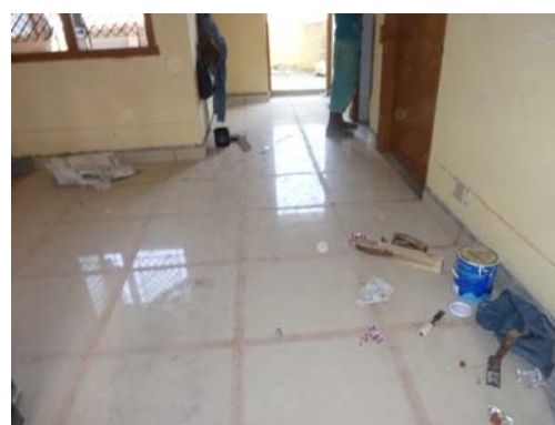
図 8 事務所の改修工事
