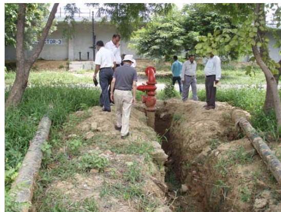
図 2 撤去状況の視察
