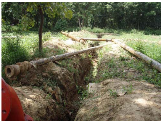
図 1 埋設管の撤去の様子
