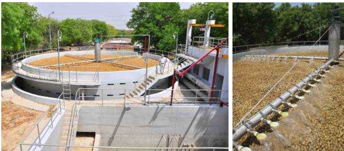
写真3 アグラ市の下水処理場に建設した DHS リアクターの全景
