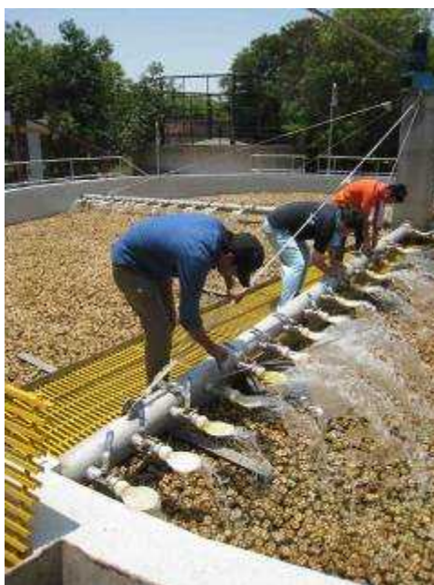
写真4 自走式散水装置の回転速度調整の様子
