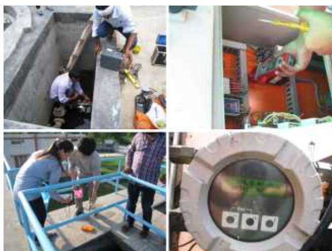
写真 9 下水処理場調査の様子
