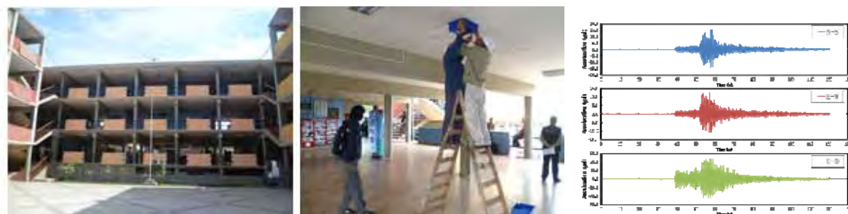
図 4.3.2 リマ市内の複数の建物にネットワーク強震計を設置し、日本からインターネット経由で地震時の建物性能をモニタリングできるシステムを構築した。地震発生時に最大応答値をメールで自動送信する機能も備えている。すでに多くの記録が得られており、建物の地震時挙動の解明に活用が期待される。
