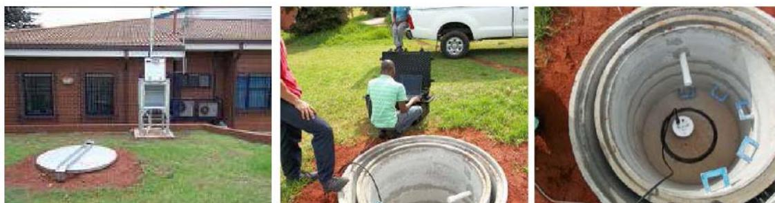
写真 2 各観測点(図 7 参照)では、岩盤に達するまで、あるいは、最低 2m の表土が取り除かれ、地震計が設置された。データは GPRS 無線電話通信によってプレトリアの CGS まで転送されている。
