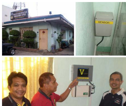
オロンガポ市防災課での震度計設置作業
