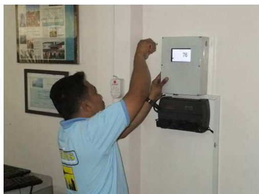
タガイタイ観測所の震度計設置作業
