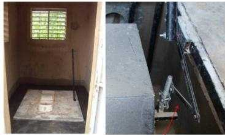
図 4-2.2 リンク機構を用いたレバー型攪拌装置
