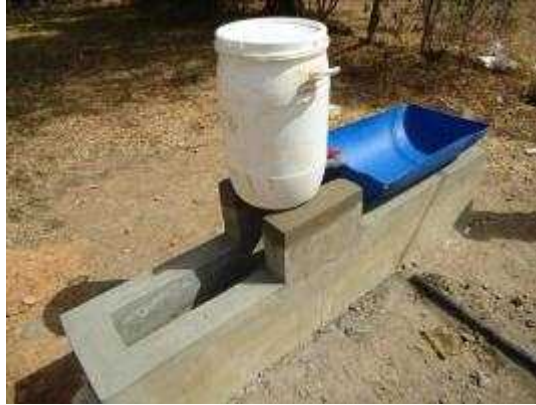
図-4. 3. 4 パイロット家庭用雑排水処理装置
