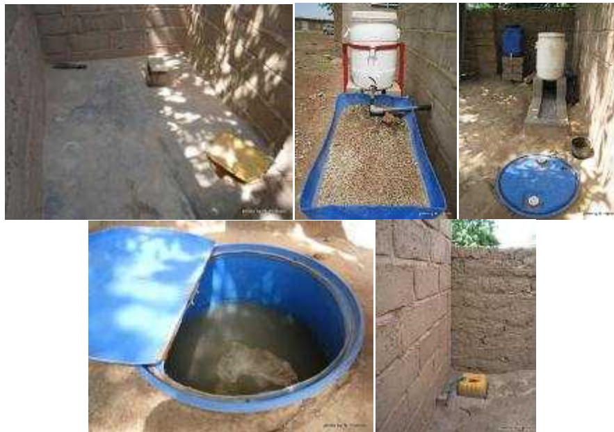
図-4. 7. 5 パイロットサイトに設置され使用を開始したシャワールーム
