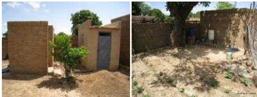
図-4. 7. 2 パイロットサイトに設置されたコンポストトイレ(写真左・右建物)、シャワールーム(写真左・左建物、写真右・奥)、菜園(写真右・手前)
