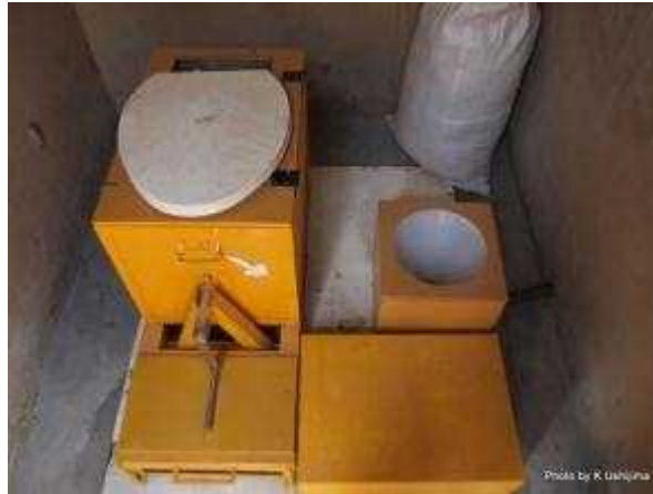
図-4. 7. 4 パイロットサイトに設置された腰かけ式モデルとビデ
