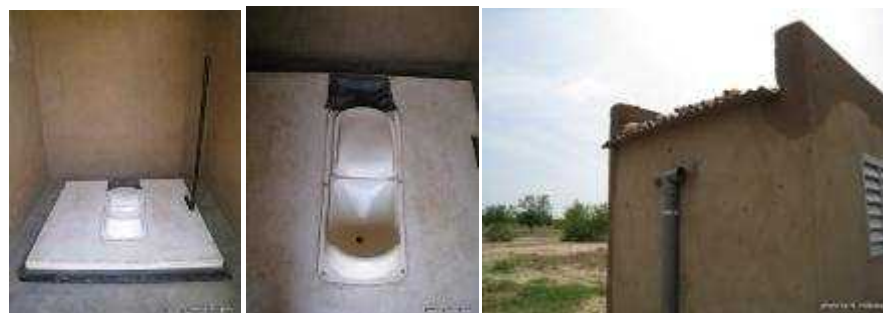
図-4. 7. 3 パイロットサイトに設置され使用を開始したコンポストトイレ トイレ内観(左)、尿尿分離型便器(中)、トイレ外背面(右)
